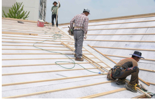
(가로상 및 방수시트 설치)
