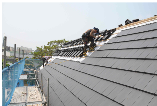
(바닥기와 시공 모습)
