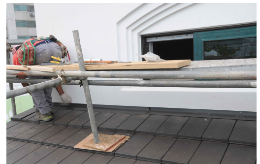
(벽체와 지붕이 만나는 부분의 후레싱 설치)
