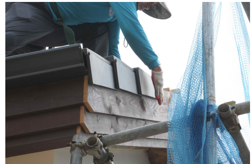
(4) (우갓기와 시공 모습)
