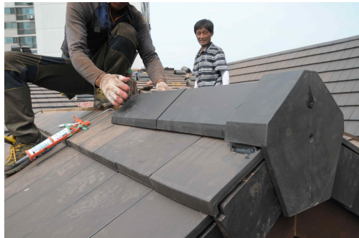
(박공기와 후 용마루마감기와 설치)
