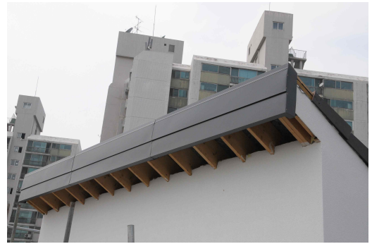
(외지붕 마감후레싱 설치)
