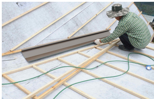
(벨리 후레싱 설치)
