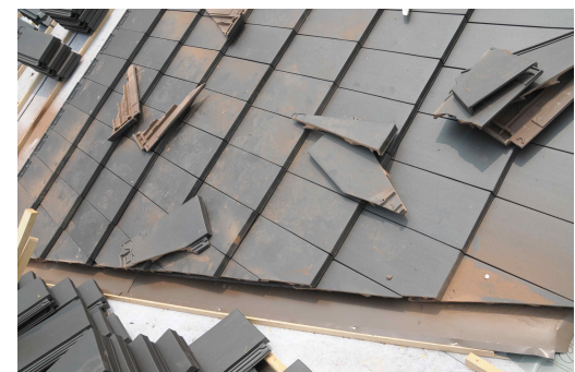
(다미골 바닥기와 설치 모습)
